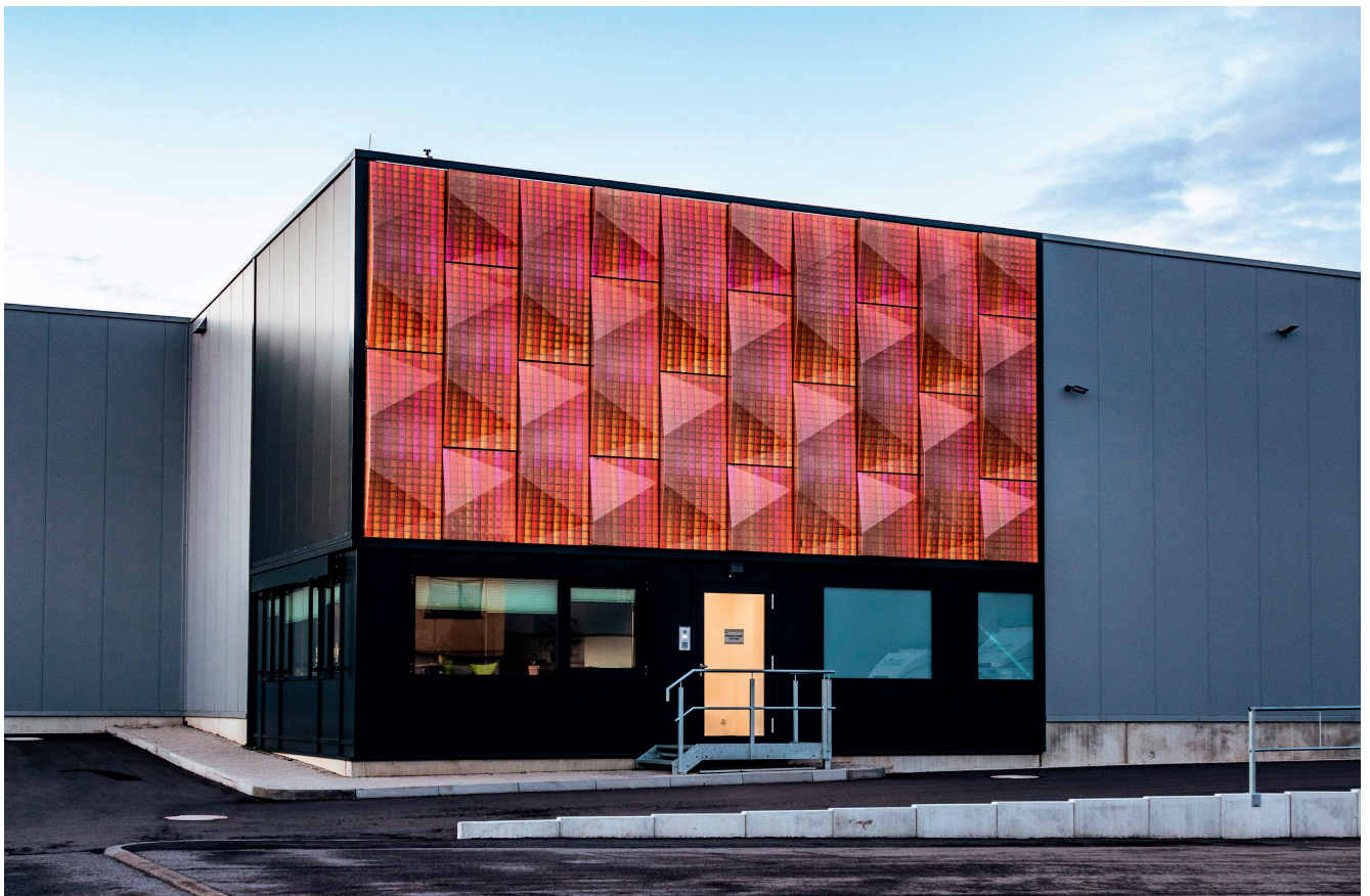
Die 50 m 2 große, biobasierte, dreidimensionale Fassade mit integrierten LEDs. Sie ist frei programmierbar und kann Bilder sowie Videos abspielen
