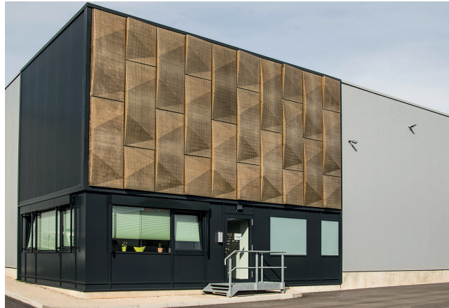
Bild 4. Nachdem die Fassade die Kriterien für „Tragende Kunststoffbauteile im Bauwesen“ sowie der Energieeinsparverordnung erfüllt hatte, folgte der Praxistest. Das Bild zeigt die dreidimensionalen Elemente unbeleuchtet (© Silvia Giardino Photography)
