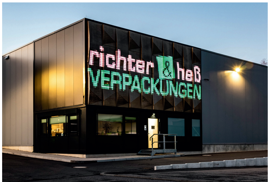
Bild 5. 14400 LEDs machen die nachhaltige Gebäudehülle zur Medienfassade. Umgesetzt wurde dies an der Produktionshalle eines Projektpartners (© Silvia Giardino Photography)
